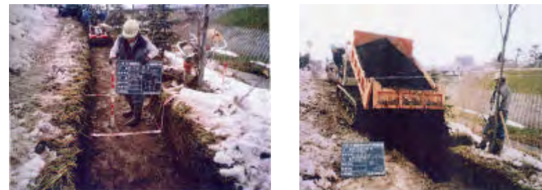
写真－6－3 列状客土の施工
