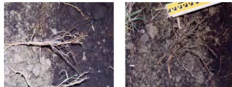
写真－6－4 施工 1 年後の根の状態
